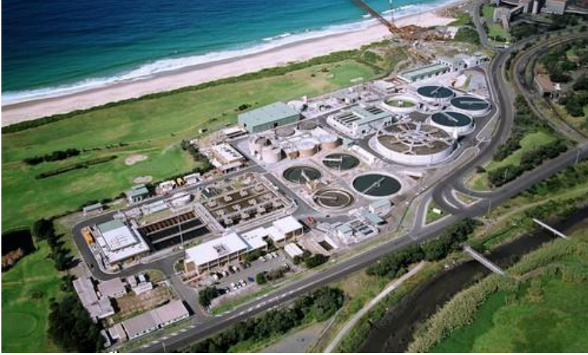
Şekil 5-4 Wollongong Atıksu Arıtma Tesisi [85]
