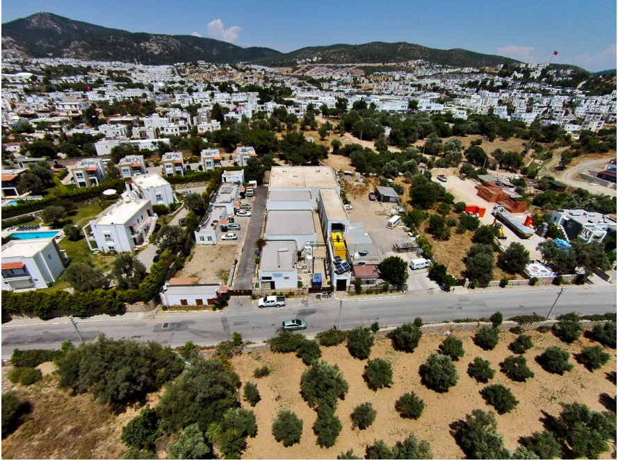
Şekil 3-4 Muğla Konacık Belediyesi Atıksu Arıtma Tesisi [66]
