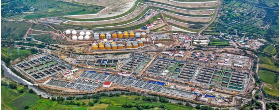
Şekil 5-12 Arıtılmış suyu sulamada kullanan Atotonilco Atıksu Arıtma Tesisi [90]
