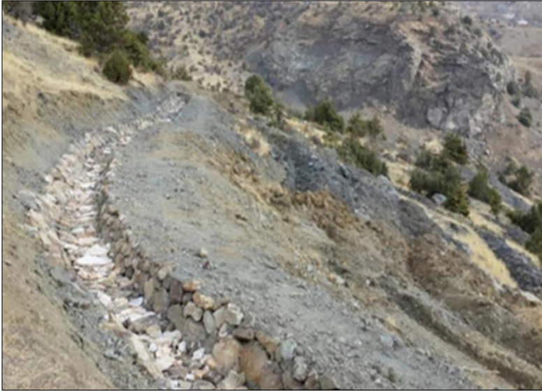
Şekil 2-21 Hendek Oluřturma Teknięi (Trenches) Uygulaması – Islak Cephesi Taş Kaplamalı [51]
