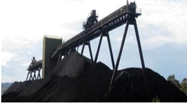
Şekil 5-68 Oceanic Kömür Yıkama Tesisi
