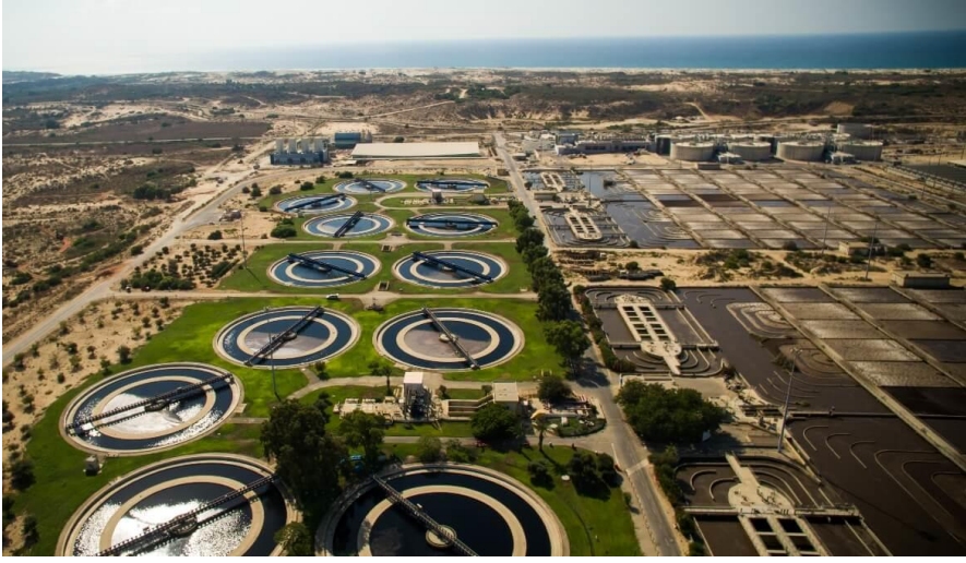
Şekil 5-80 Dan Bölgesi su geri kazanım tesisi
