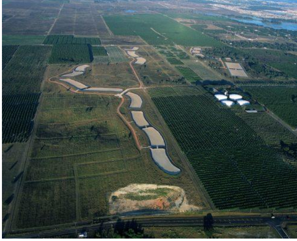
Şekil 5-20 Hızlı infiltrasyon havuzlarının havadan görünümü [95]
