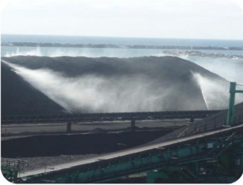
Şekil 5-2 Wollongong Su Geri Kazanım Tesisi sularının kömür depolarında oluşan tozun bastırılmasında kullanımı [85]
