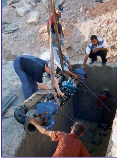
Şekil 1. By-pass borusunun montajı (GWLR, 2011)
