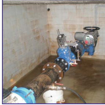
Şekil 8.7. DMA girişine yerleştirilen bir PRV (basıncı düşürücü vana) ile su basıncı istenilen seviyeye indirilebilir.
