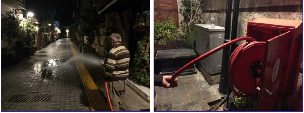
Şekil 3.8. Yangın hidrantlarından izinsiz su kullanımı
