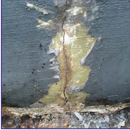
Şekil 4.4. Depo sızıntısı ve kaçakları
