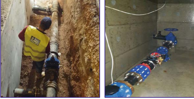
Şekil 3. Alt bölge odaları inşaatı ve basınç yönetimi için basınç düşürücü vana montajı
