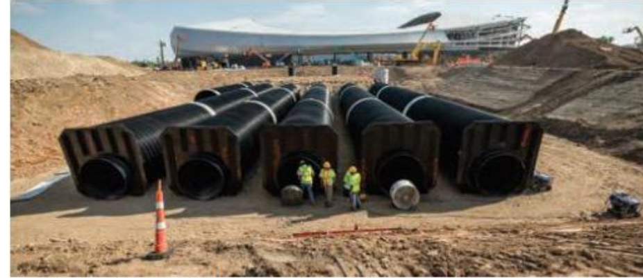
Şekil 3.21 St.Paul, MN, Allianz Field Yeraltı Yağmur Suyu Depolama Tankının Kurulumu
