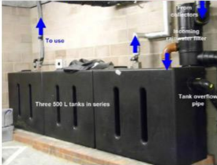
Şekil 3.15 Londra'daki Rafayel Hotel'den Yağış Toplama (yukarıda) ve Depolama (aşağıda) Sistemine Bir Örnek
