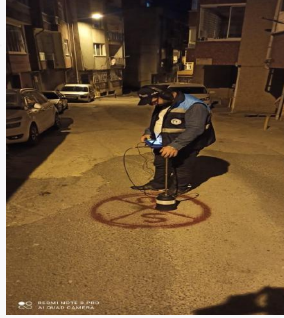
22-A Nolu Alt Bölge Akustik Kaçak dinleme Uygulaması
