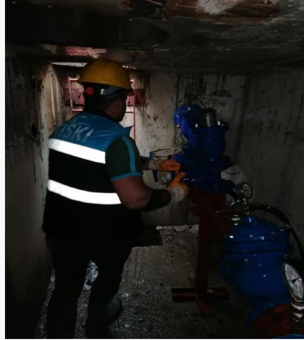
22-A Nolu Alt Bölge Basınç Kırıcı Uygulaması
