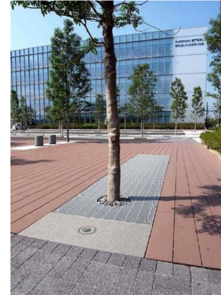
Şekil 103. Ağaç altı yanlış mazgal kullanımı
