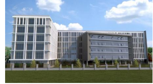
İl Müdürlükleri Hizmet Binası
