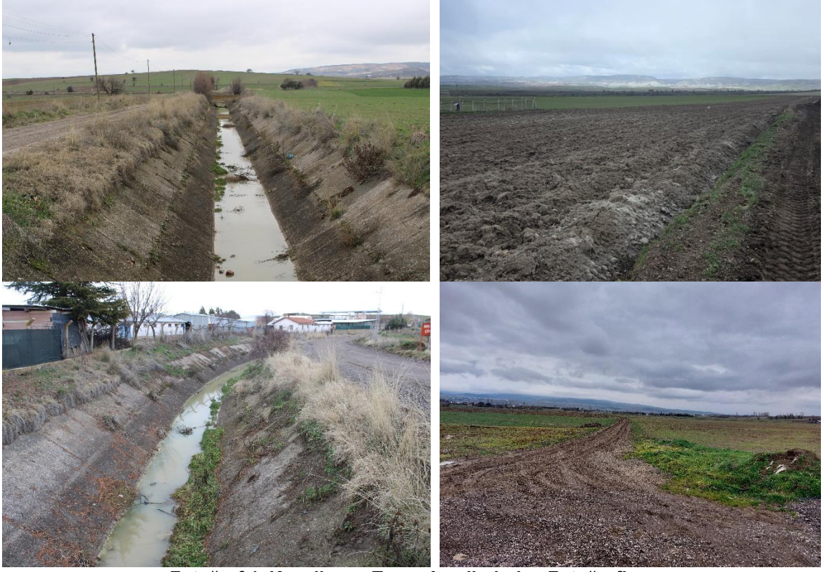
Fotoğraf 1. Kanallar ve Tarım Arazilerinden Fotoğraflar
