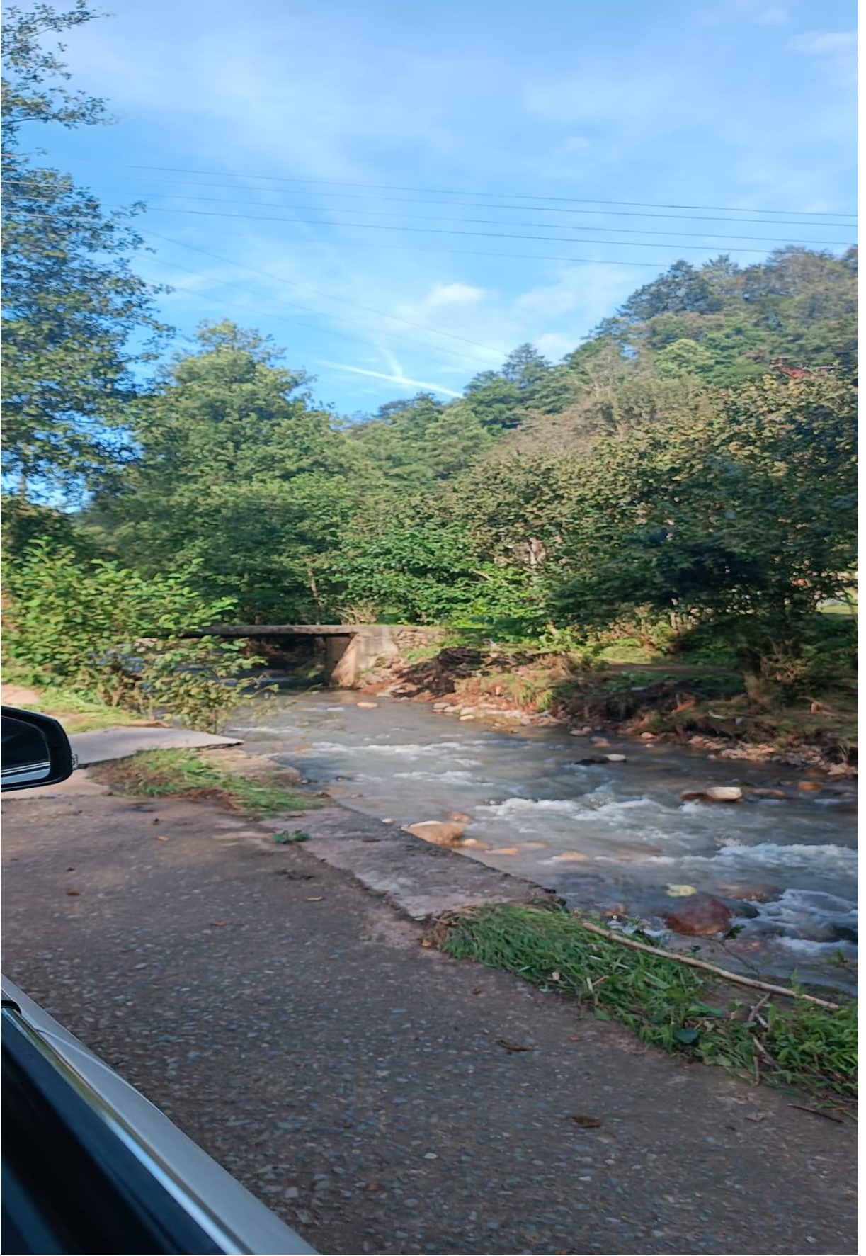
Rehabilitasyon için Planlanan Taşıt Köprüsü
