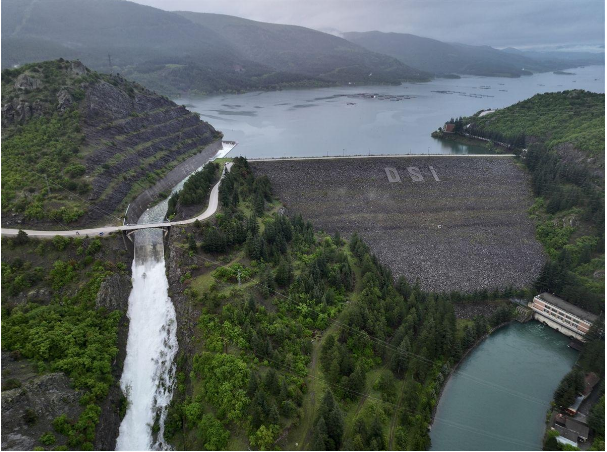
Fotoğraf 8. Almus Barajı Genel Görünüm
