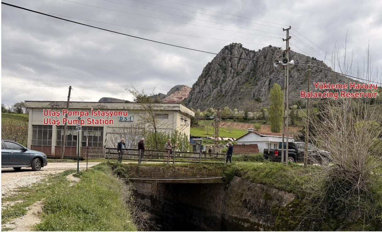
Fotoğraf 3. Ulaş Pompa İstasyonu ve Yükleme Havuzu İçin Öngörülen Yaklaşık Konumlar
