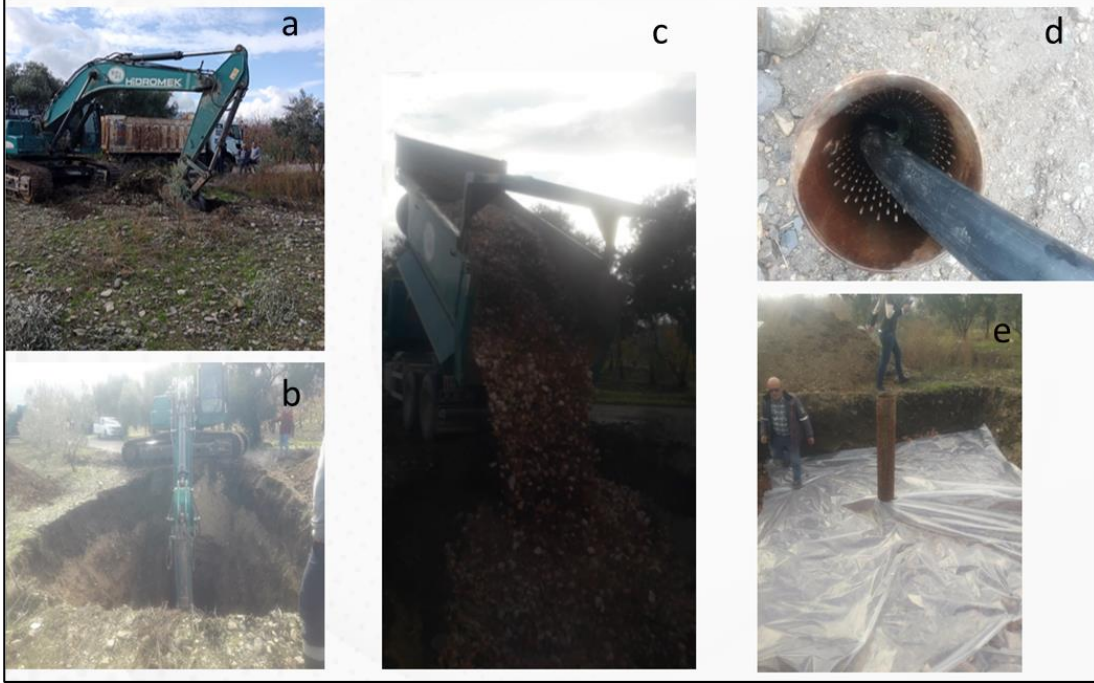
Şekil 4. Sinancılar 1 yeraltı suyu suni besleme çalışmaları. (a-b. besleme çukurunun ekskavatör ile açılması, c. çukur içerisine filtre malzemesinin (çakıl) dökülmesi, d. filtreli borunun yerleştirilmesi, e. koruyucu malzemenin serilmesi.)
