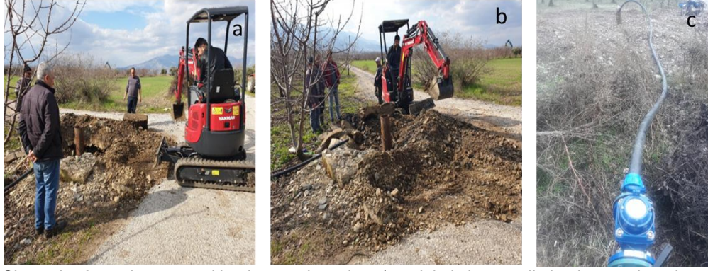
Şekil 6. Sinancılar 2 yeraltısuyu suni besleme çalışmaları. (a. mini ekskavatör ile besleme çukuru kazısının yapılması; b. saha kontrolü; c. debi ölçüm ekipmanının (su sayacı) kurulumu )
