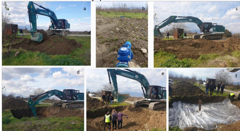
Şekil 5. Sinancılar 3 suni besleme çalışmaları. (a. Ekskavatör ile kazı çalışması; b. debi ölçüm ekipmanının (su sayacı) kurulumu; c. Besleme çukuru kazısının tamamlanması. d. besleme çukurunun derinleştirilmesi. e. Saha incelemesi sırasında teknik personelin besleme alanını yerinde değerlendirmesi. f. Koruyucu malzeme serilmesi işlemi.)
