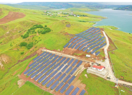
🔥 Tunceli Pompaj Sulaması GES
