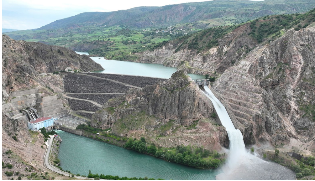
🔥 Kılıçkaya Barajı ve HES
