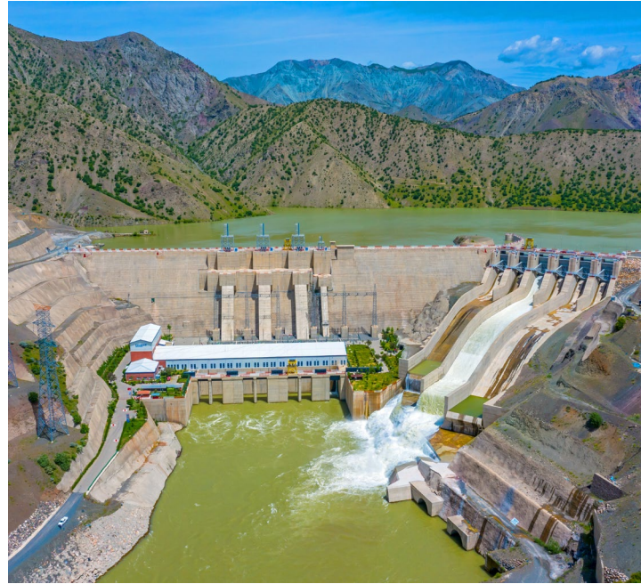
Elazığ Beyhan 1 Barajı ve HES
