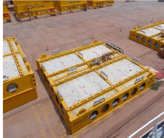
e) Çelik Profiller İçine Yerleştirilmiş Ankraj Blokları
