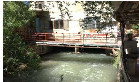
Şekil 11- Sorkun Köyü taşkın tesisi üzerine yapılan müdahaleye ait görüntü
