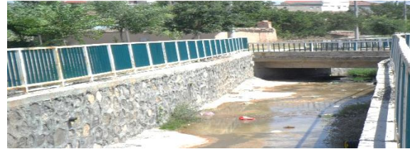
Şekil 16- Bulduk Kasabası taşkın koruma tesisinde kesiti daraltan yol geçişine ait görüntü
