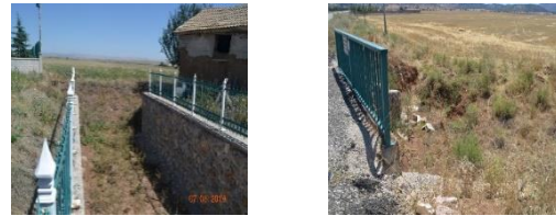
Şekil 3- Kamulaştırma sorunundan memba kısmı tamamlanamamış tesise ait görüntü
