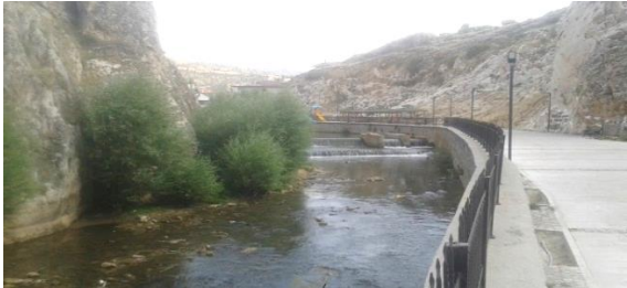
Şekil 7- Tesis mansabında yapılan ve taşkın riskini artıran regülatör yapısına ait görüntü
