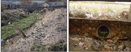
Şekil 17- Yunak İlçesi Turgutlar Mahallesi taşkın koruma tesisi üzerine yapılan okul ve okul bahçesi altından geçen kapalı kesit
