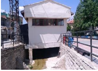
Şekil 12- Başarakavak Mahallesi taşkın tesisi üzerine yapılan müdahaleye ait görüntü
