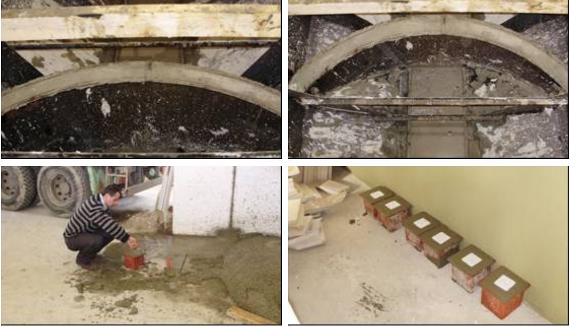
Şekil 12 - Beton dökümüne ait görüşler
