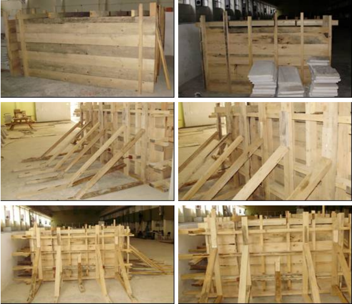
Şekil 10 - (270 x 130) cm 2 boyutlu yüzey için hazırlanan panel kalıp planı
