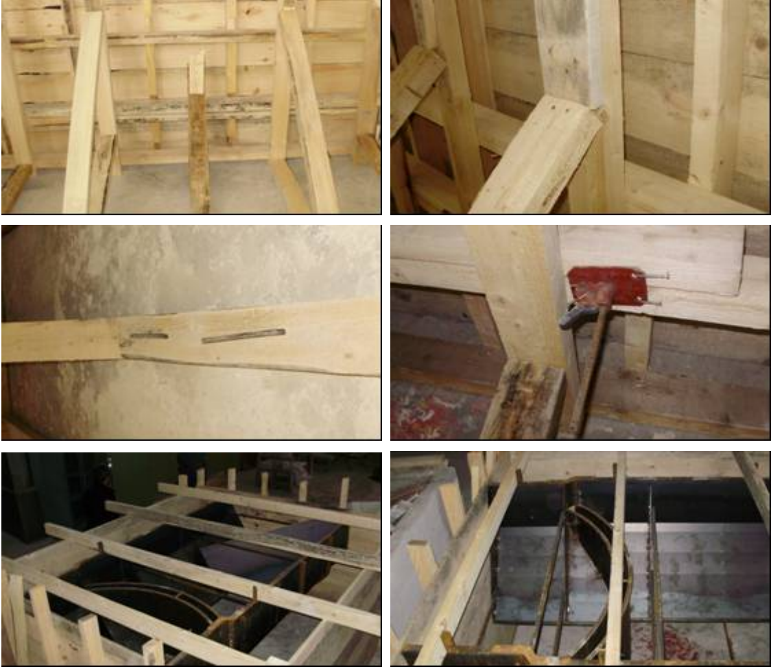
Şekil 11 - Ahşap kalıbın yapımına ait görünüşler
