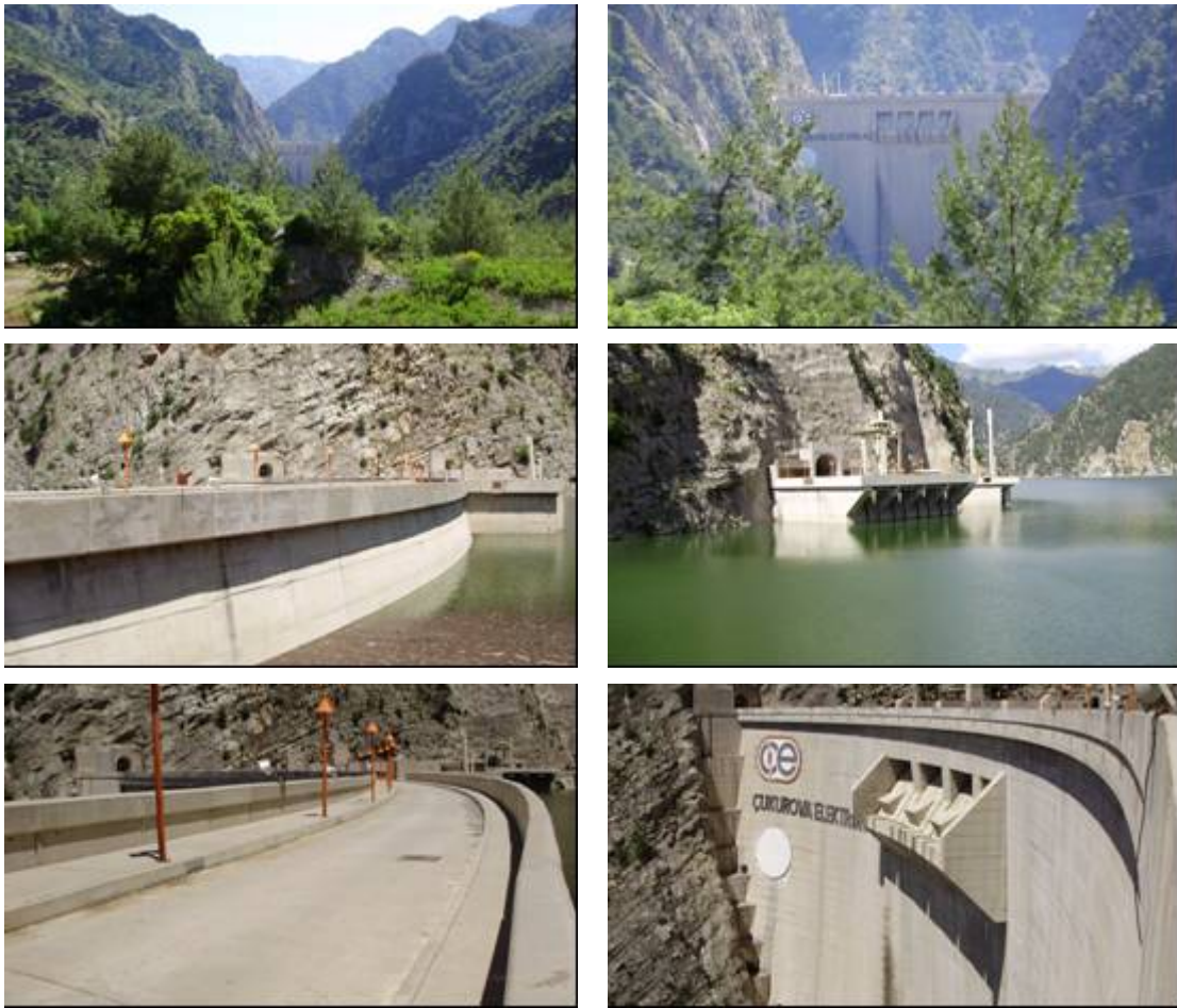
Şekil 2 - Berke Barajı'na ait bazı fotoğraflar
