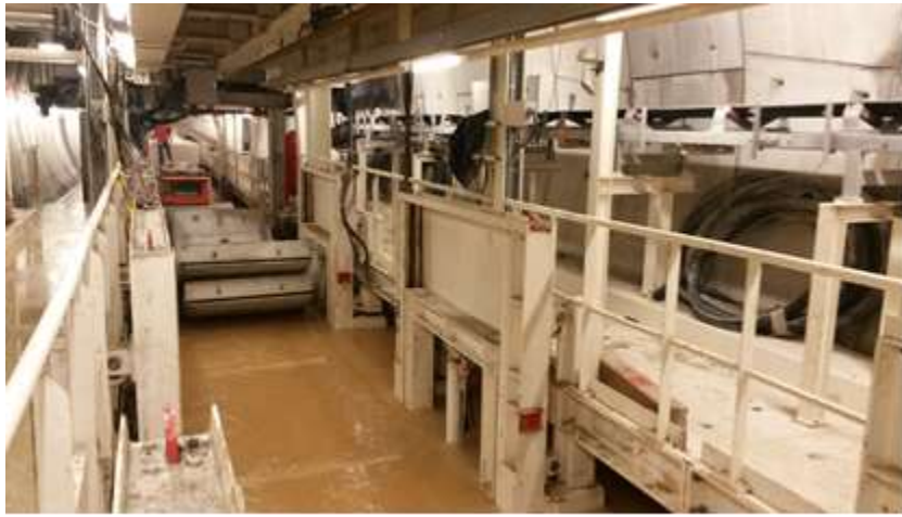
Resim 2 - Silvan tüneli kazısı sırasında karşılaşılan su çıkışı
