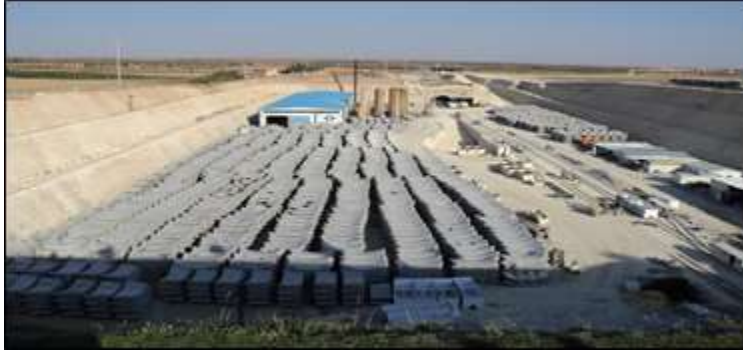
Resim 5 - Tünel delme makinesi giriş platformu
