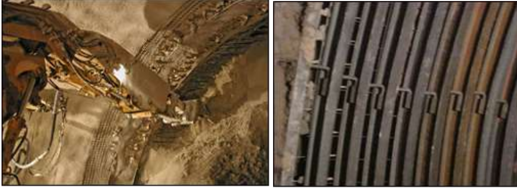
Resim 3 - Tünelde püskürtme betonu, süren ve çelik iksa uygulaması
