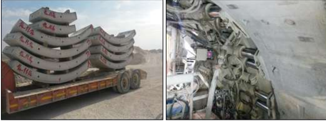
Resim 7 - Segment taşınması ve segmente TDM'nin piston etkisi
