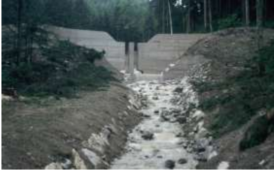
Resim 5-6 - Yatak yükünün ayıklanması ve sel suyu miktarını ayarlayan süzücü bent
