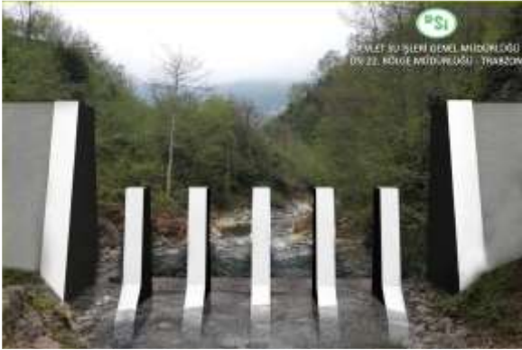
Görsel-1 - Ayaklı süzücü bent tipi ve yurt dışında uygulanmış örneği
