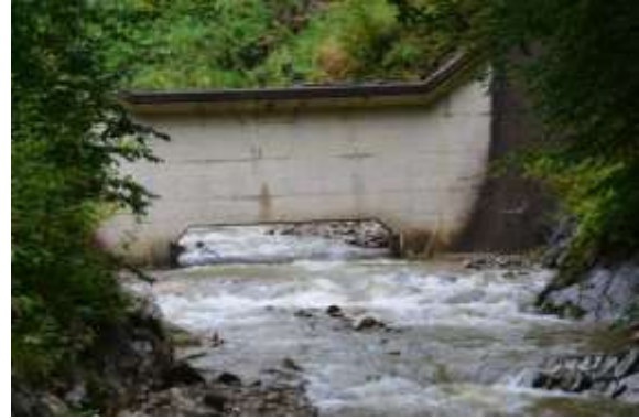
Görsel-1 - Dip açıklıklı süzücü bent tipi ve yurt dışında uygulanmış örneği
