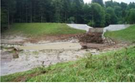
Resim 3-4 - Odunsu taşıntıyı tutan ve sel suyu miktarını ayarlayan süzücü yapılar
