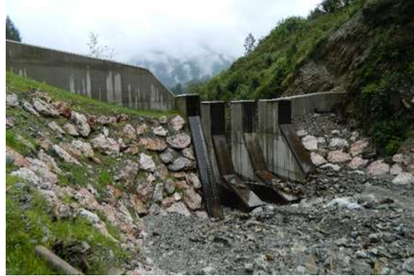
Görsel-1 - Ayaklı süzücü bent tipi ve yurt dışında uygulanmış örneği
