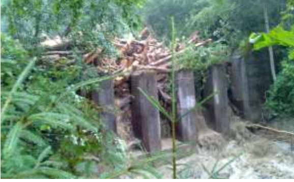
Resim 1-2 - Oduncu taşıntısının tutulmasını sağlayan süzücü bentler
