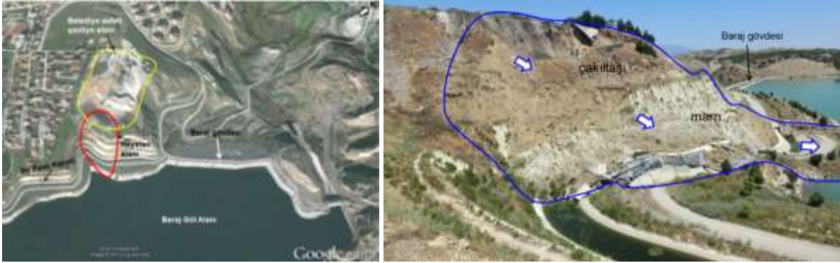
Şekil 2 - Gökpınar barajı sol sahil heyelan alanının uydu görüntüsü ve heyelan kütesinin görünümü
