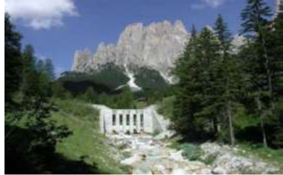
Resim 5-6 - Yatak yükünün ayıklanması ve sel suyu miktarını ayarlayan süzücü bent
