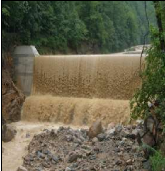
Şekil 3 - Menba tesisi örneği (Münferit ıslah sekisi)
