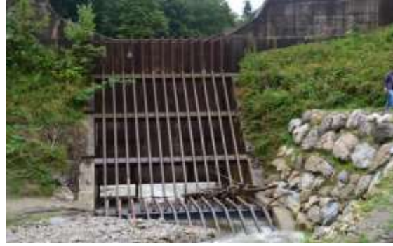
Resim 3-4 - Odunsu taşıntıyı tutan ve sel suyu miktarını ayarlayan süzücü yapılar
