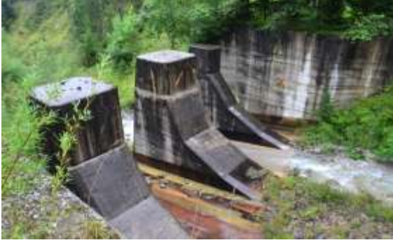
Resim 7-8 - Kaba rüsubat tutma ve enerji kırma işlevi gören süzücü bentler
