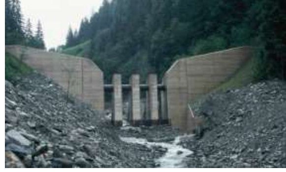
Resim 7-8 - Kaba rüsubat tutma ve enerji kırma işlevi gören süzücü bentler
