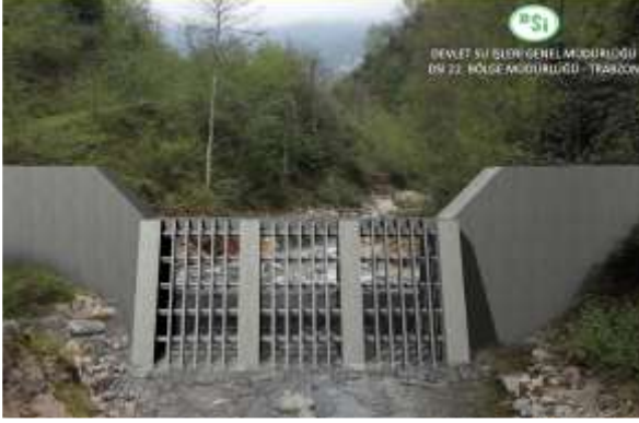
Görsel-1 - Ayaklı ve ızgaralı süzücü bent tipi ve yurt dışında uygulanmış örneği
