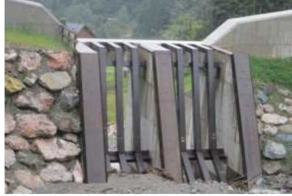
Görsel-1 - Ayaklı ve ızgaralı süzücü bent tipi ve yurt dışında uygulanmış örneği
