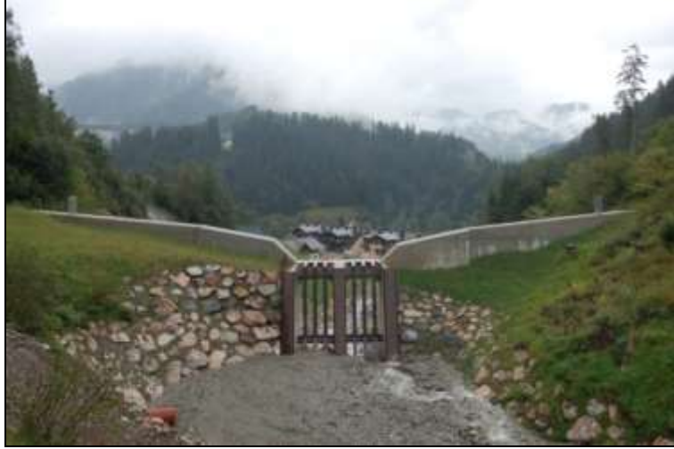
Şekil 13 - Geçirgen tersip bendi örneği (Avusturya)
