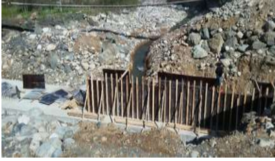
Resim 11 - Rize ili Güneysu ilçesi Güneysu deresi Geçirgen Bent İnşaata
