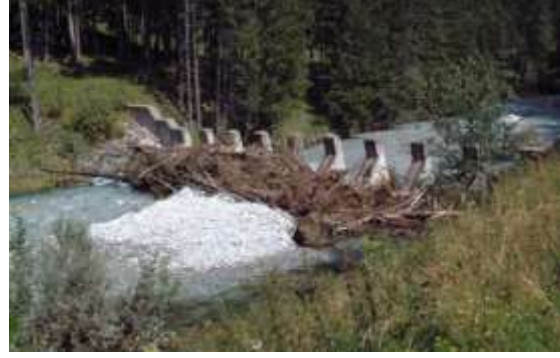
Resim 1-2 - Oduncu taşıntısının tutulmasını sağlayan süzücü bentler
