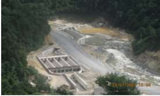
Resim1.1.Su alma yapısı (Regülatör) yapımı aşaması
