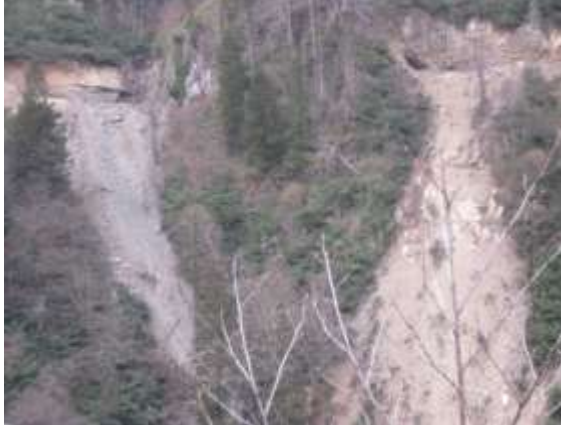
Resim 1.2. Su iletim hattı inşaatı Hidroelektrik santrallerin yapımı aşamasında meydana gelen bu tehditlerin ortadan kalktığı gerçeği, inşaat süreçlerinin bitmesi ve üretime geçilmesi ile birlikte görülmüştür.
