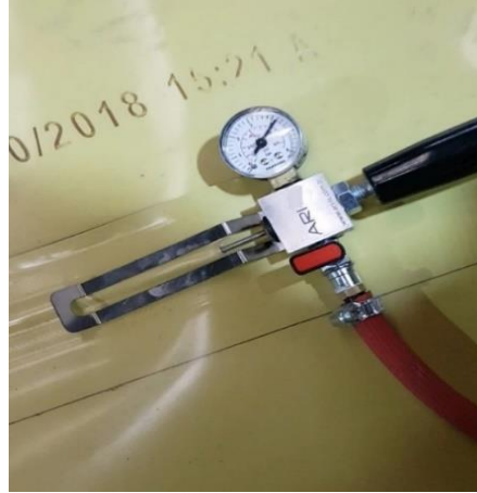
Şekil 5 – PVC malzemesi kaynağının hava basıncı testinde gösterge 4.0 bar üstündedir
