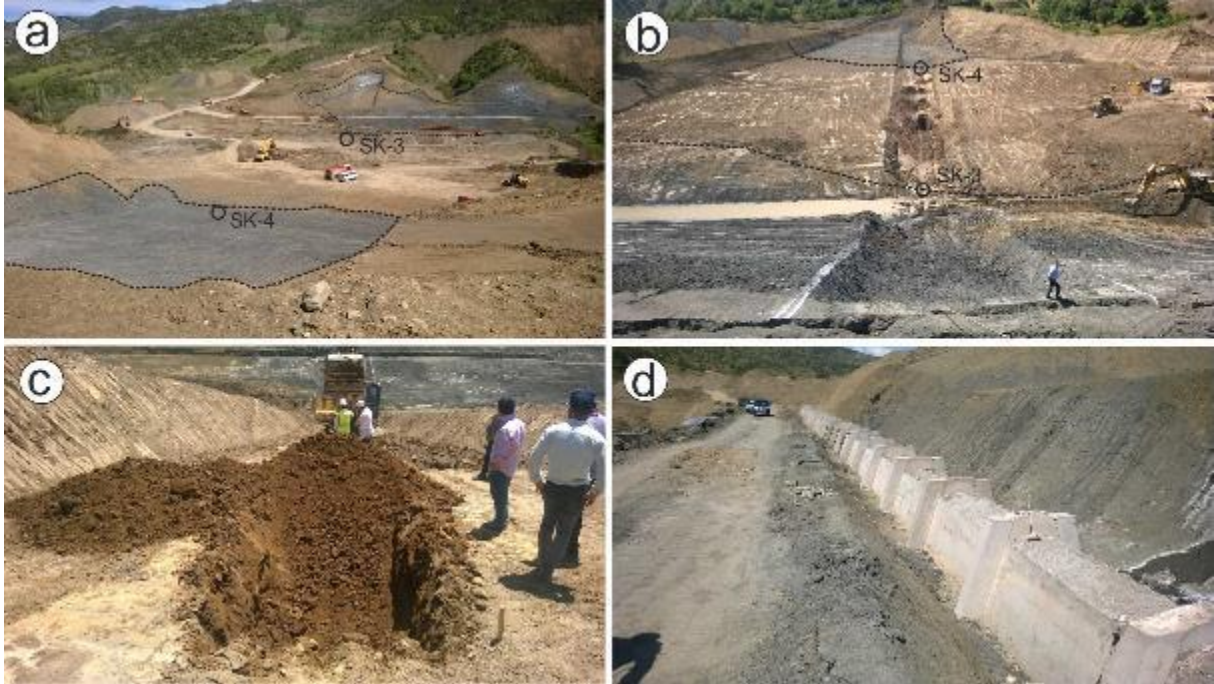
Şekil 11 - Derekargın göletinde SK-3 ile SK-4 kuyuları arasında kazılarak alınması gereken kahverengi gevşek zemine (Pliyosen) ve gövdenin oturacağı gri renkli sağlam kayaya (Eosen) sağ yamaçtan (a) ve sol yamaçtan (b) bakış, gevşek zeminin daha yakından görünüşü (c) ve sol yamaçta kondüvinin oturduğu sağlam Eosen kumtaşı-marn-silttaşı tabakaları (Foto: Hasan Deveci)
