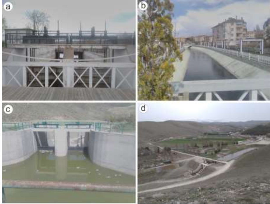
Şekil 2- Mogan Gölünün boşalmasını kontrol eden regülâtör (a) ve devamındaki kanal (b), Eymir Gölünün boşalmasını kontrol eden regülâtör (c, d)
