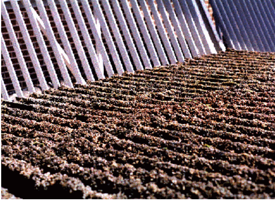
Şekil 7 - Su alma yapılarında ızgaralarda zebra midye sorunu
