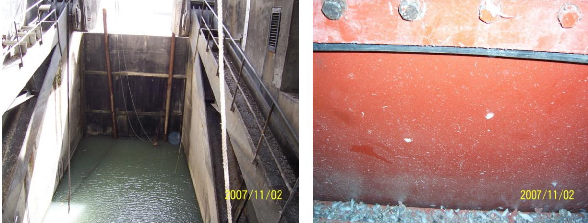
Şekil 26 - Şanlıurfa T2 tüneli çıkış kapağında boya uygulaması (silikon esaslı boya)
