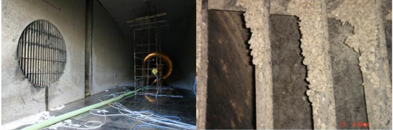
Şekil 23 - İçme suyu ham su giriş ağzı ızgaralarında biriken zebra midyeler
