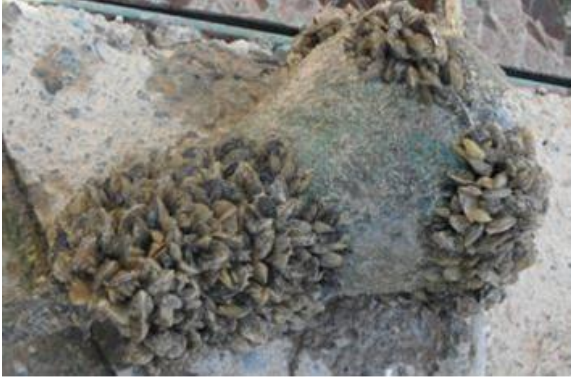
Şekil 50 - Pompa istasyonu girişinde tespit edilen zebra midye görüntüleri
