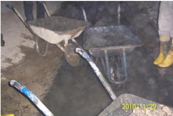
Şekil 19 - Yaslıca tüneli'nde zebra midyelerin mekanik olarak temizlenmesi
