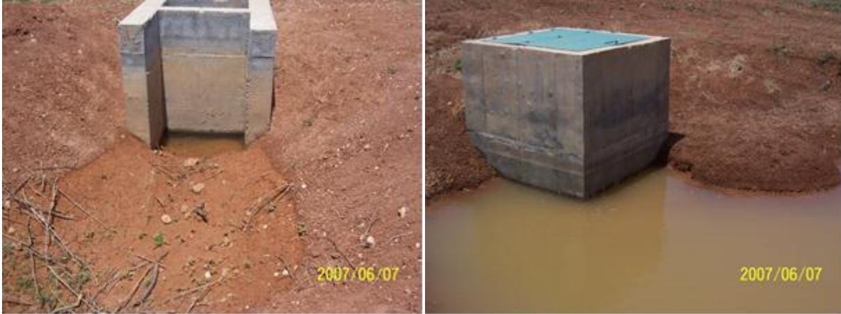
Şekil 29 - Harran sulaması 1070 yedeğinde drenaja bağlanmamış uç tahlieleri
