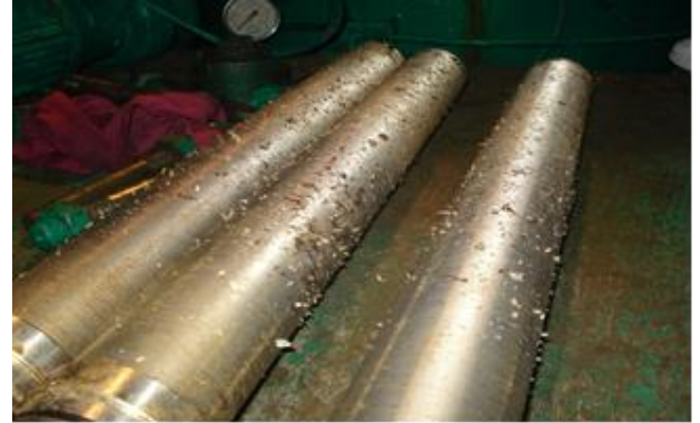
Şekil 18 - Atatürk Barajı HES soğutma sisteminde serpantin temizliği
