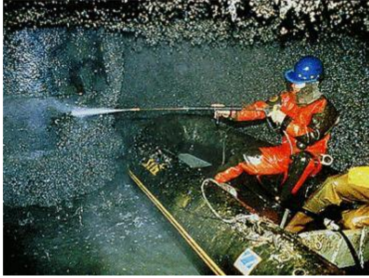
Şekil 12 - Yüksek basınçlı su püskürterek zebra midye savaşı (ZMIS, 2001).
