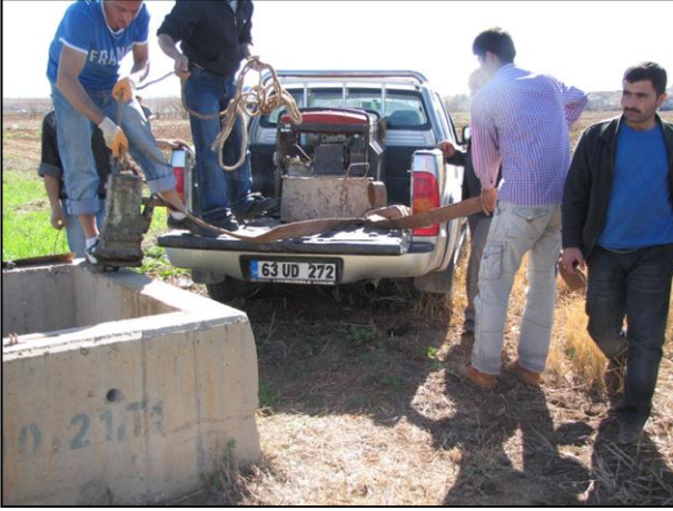
Şekil 32 - Yaylak sulaması 1400. 21 uç tahliyesinin motopomla tahliyesi
