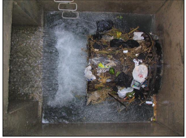
Şekil 15 - Harran sulaması 1070 hattında krepin yapısı
