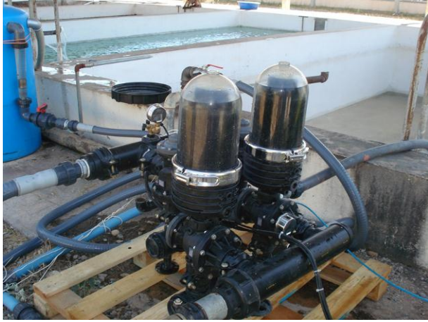
Şekil 36 - Arkal diskli filtresi
