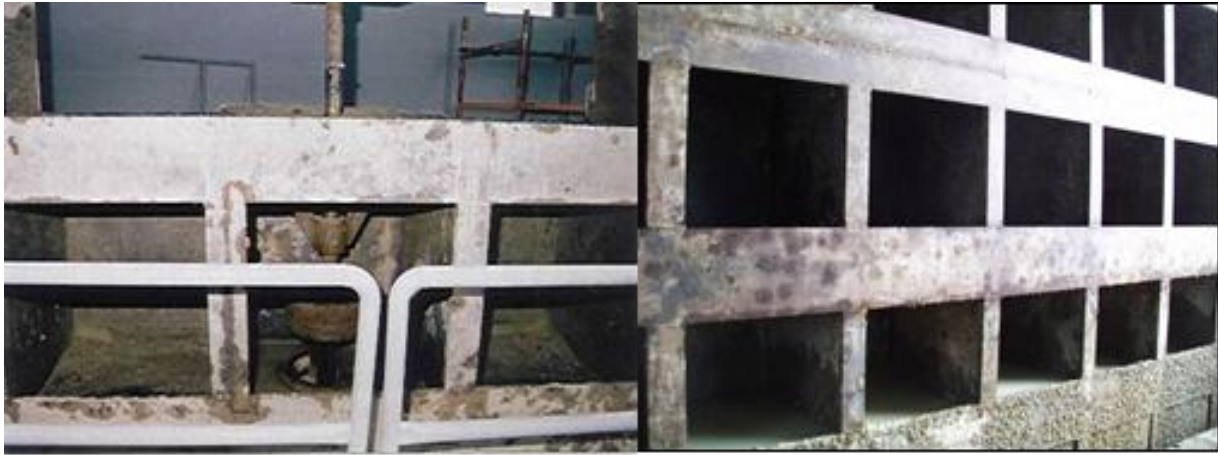
Şekil 28 - Şanlıurfa tünel kapaklarında zebra midyeye karşı sea-nine bileşimli boyalarla yapılan uygulama
