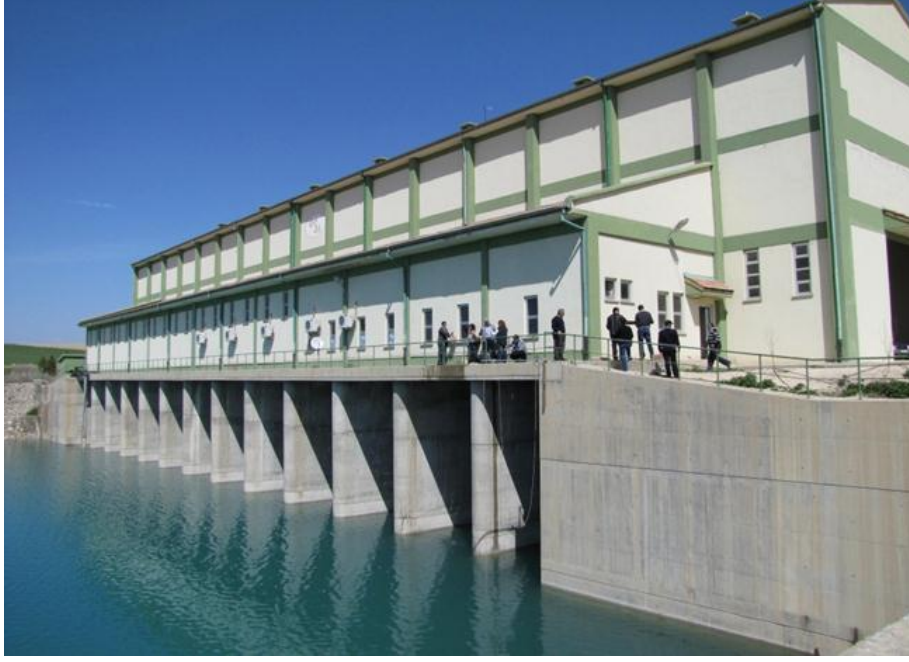
Şekil 38 - Tatarhöyük pompa istasyonu
