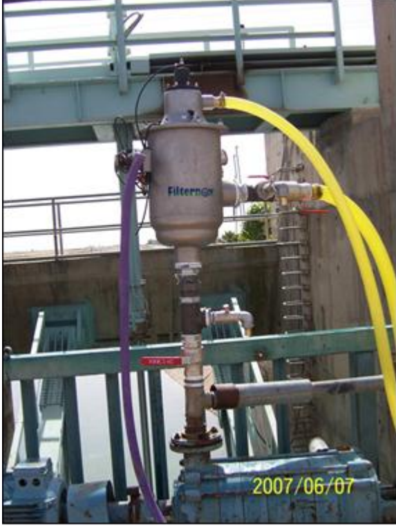
Şekil 35 - 40 µm göz aralığı olan filternox filtresi ve mikroskop görüntüleri
