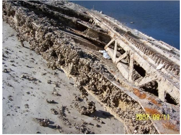
Şekil 11 - Demirköprü Barajında su alma yapısında zebra midye sorunu
