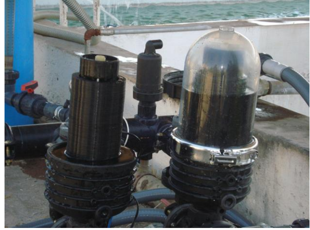
Şekil 36 - Arkal diskli filtresi
