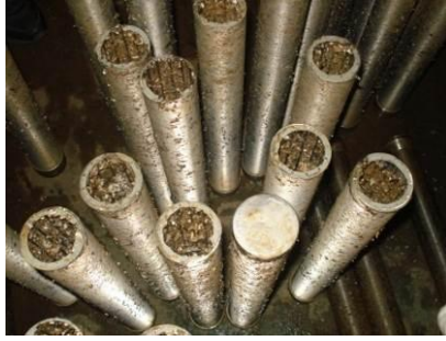
Şekil 8 - Atatürk Barajı HES soğutma serpantinleri
