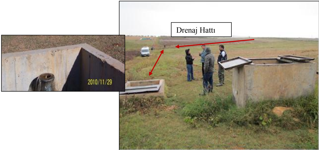
Şekil 30 - Yaylak sulaması 1400.20 drenaj hattına bağlanmamış uç tahliyesi
