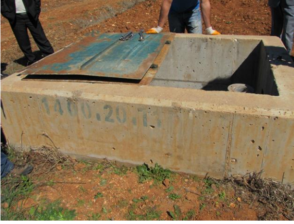
Şekil 31 - Yaylak sulaması 1400. 20 uç tahliyesi
