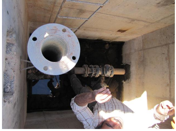
Şekil 31 - Yaylak sulaması 1400. 20 uç tahliyesi
